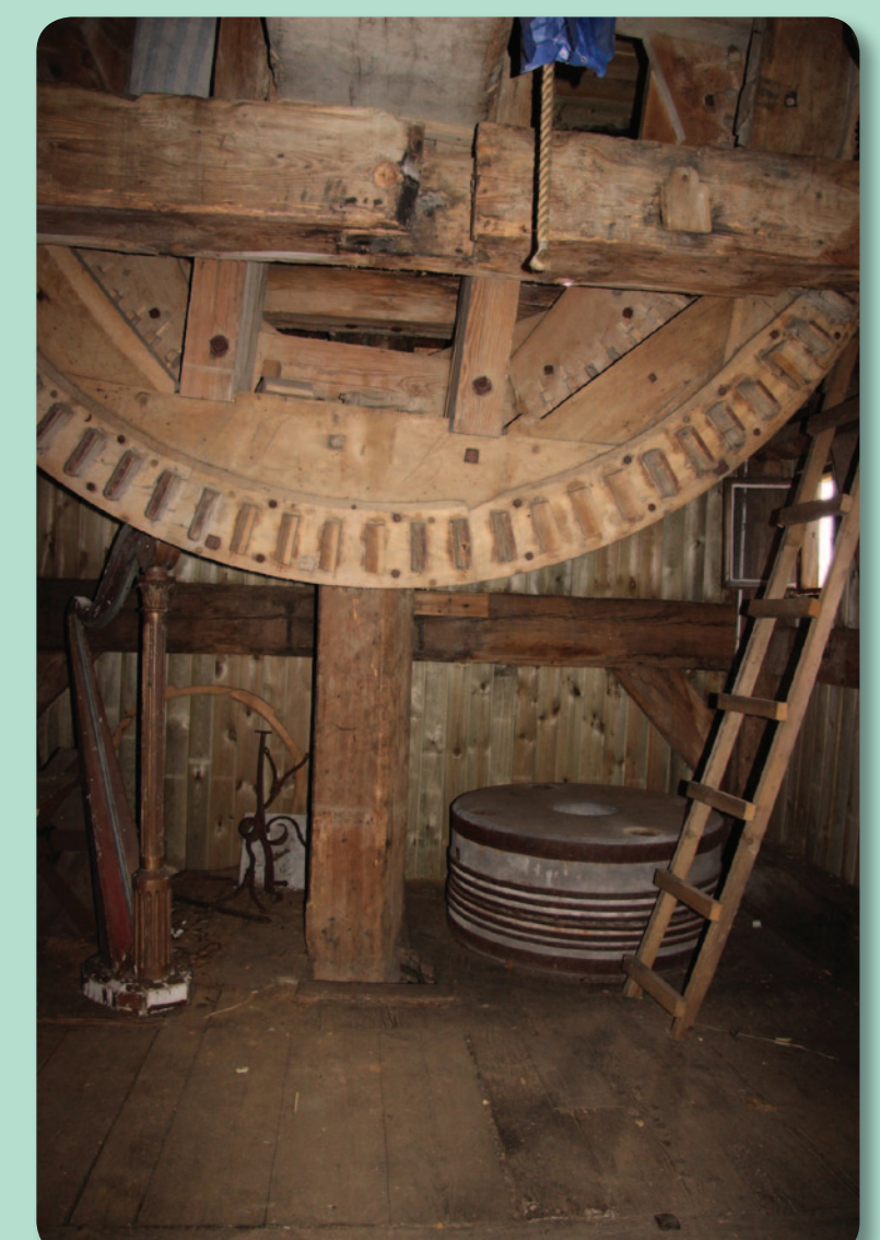
3. Wiatrak koźlak w Drewnicy z lat 40. XVIII w. Druga kondygnacja z kołem palcznym. W sztodzie widoczne gniazdo po osadzeniu sochy zaś w podłodze ślad po pierwotnym usytuowaniu kamieni młynskich (fot. M. Prarat, 2018).
