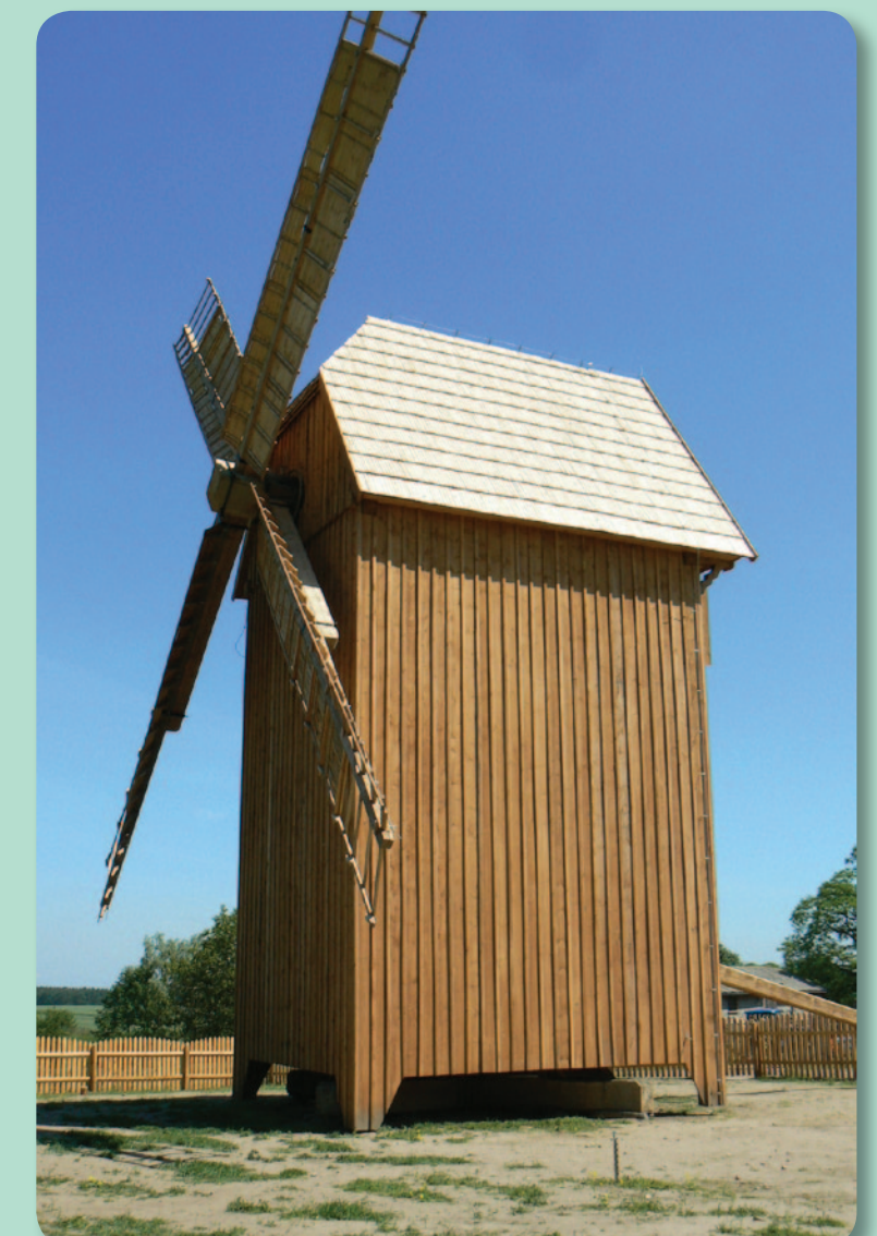
3. Wiatrak w Bierzgowie po remoncie (fot. M. Prarat, 2012).
